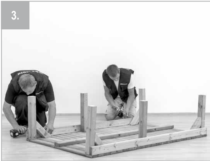
3. Die Schrägstützen (8) mit den Eckpfosten und Rahmen der Bodenplatte verschrauben, jeweils 6 Schrauben 5 x 80 mm (16) pro Schrägstütze verwenden. An die mittleren Pfosten werden die Schrägstützen (8) jeweils mit 4 Schrauben 5 x 70 mm (15) an Standpfosten und Rahmen verschraubt.
