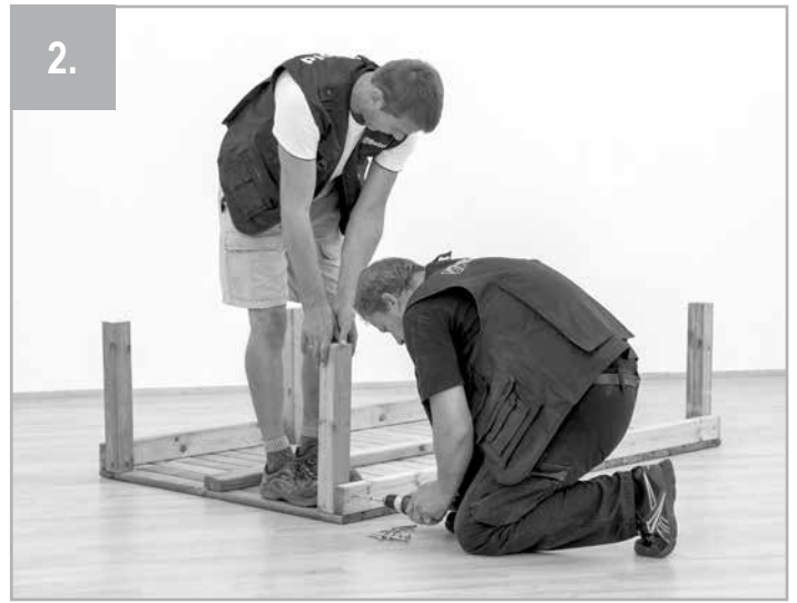
2. Montage der 6 Standpfosten (7) an der Unterseite der Bodenplatte (1) mit 2 Schrauben 5 x 80 mm (16) jeweils an den Ecken und in der Mitte der Längsseiten festmachen.
