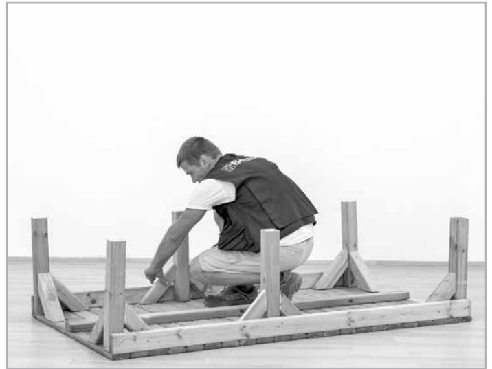
3. Die Schrägstützen (8) mit den Eckpfosten und Rahmen der Bodenplatte verschrauben, jeweils 6 Schrauben 5 x 80 mm (16) pro Schrägstütze verwenden. An die mittleren Pfosten werden die Schrägstützen (8) jeweils mit 4 Schrauben 5 x 70 mm (15) an Standpfosten und Rahmen verschraubt.
