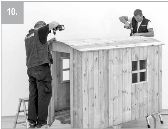
10. Das letzte Dachbrett zusätzlich mit jeweils 4 Schrauben 4 x 50 mm (14) in die Seitenwände verschrauben.
